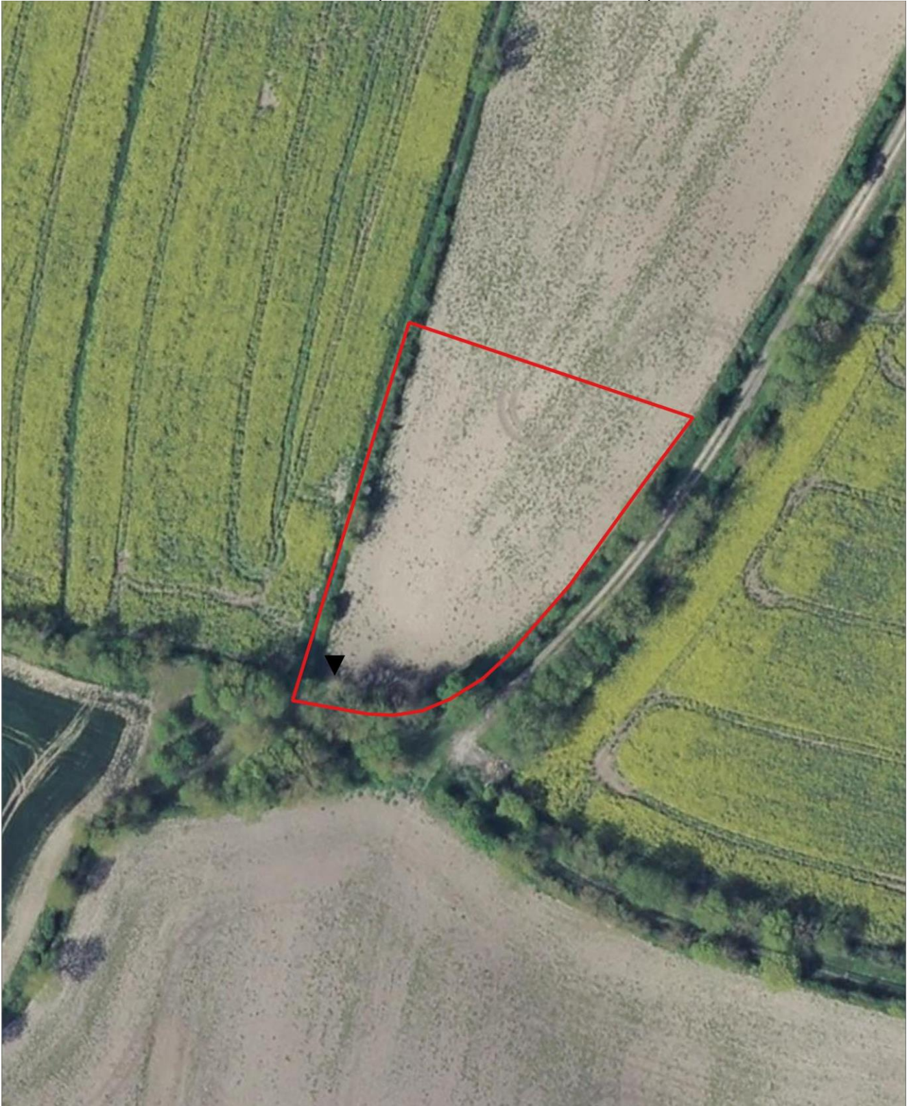
Carte 3 : Prise de vue aérienne de la zone d'implantation de la future station d'épuration
